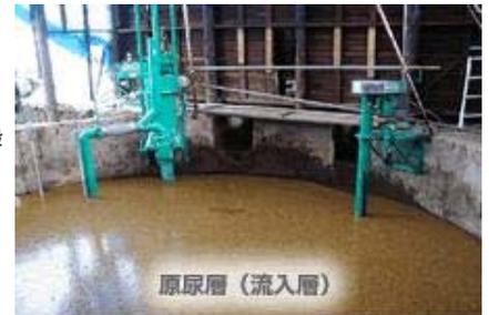
発酵タンクは2基あり、1次槽が260m<sup>3</sup>、2次槽は800m<sup>3</sup>の容量があります。糞尿は1次槽から2次槽へとオーバーフローの原理で移動します。総発酵期間は、約50日程度と思われます。
